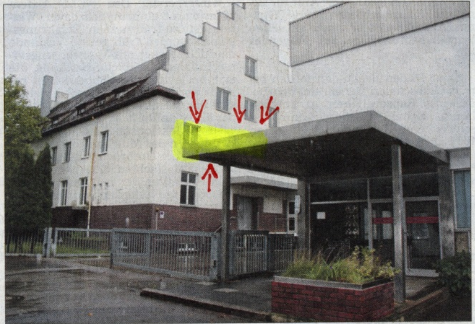
In dem Hauptgebäude an der Kilsheimer Straße (links) will Michael Hahn den Verwaltungstrakt seiner Firma unterbringen. Foto: Katrin Müller
